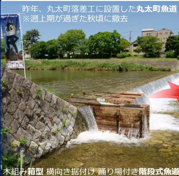
木組み箱型 横向き据付け 踊り場付き階段式魚道
